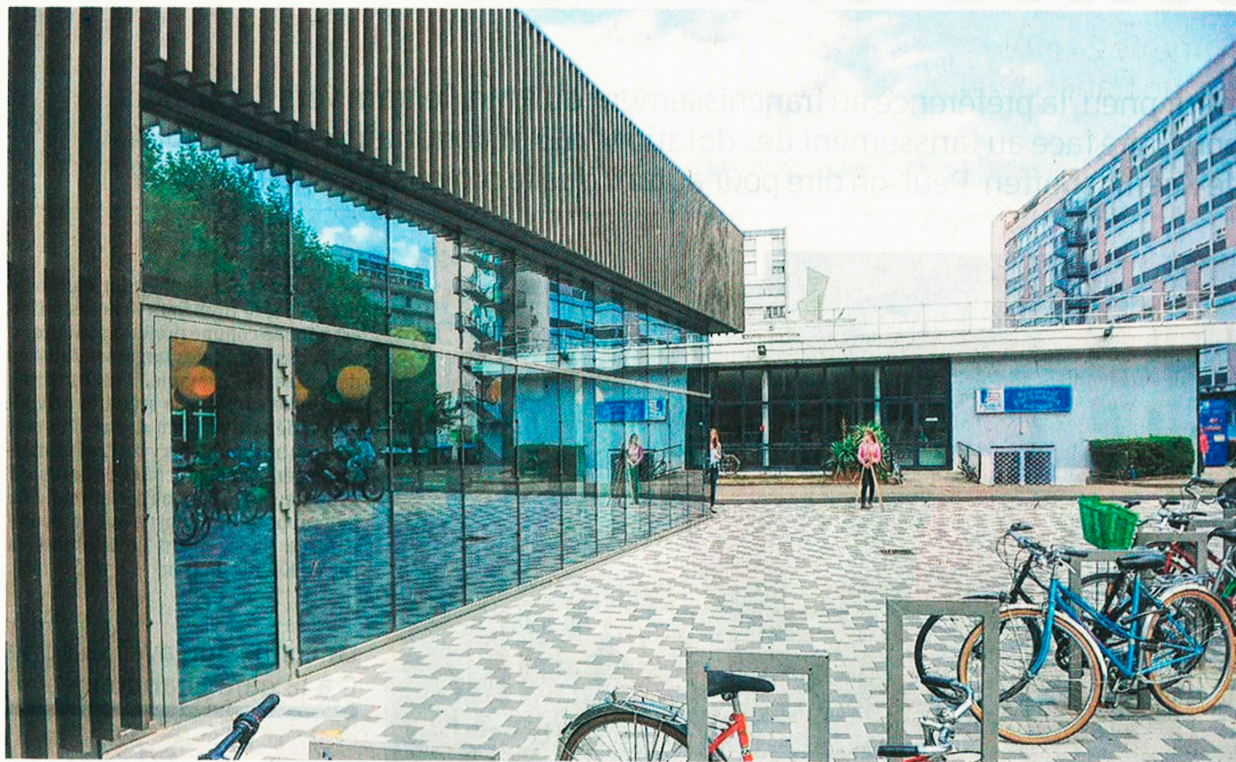
À gauche, le nouveau bâtiment de Weber et Keiling, en face l'ancien restaurant universitaire. PHOTOS DNA - MARC ROLLMANN
